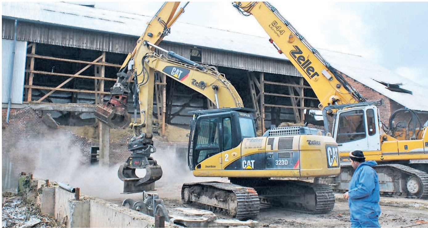
Den alten Wirtschaftsgebäuden des früheren fürstlichen Hofguts geht es an den Kragen. Nach dem Abriss soll auf dem 10 000 Quadratmeter großen Gelände ein neuer Treffpunkt im Rahmen der Dorferneuerung entstehen.
