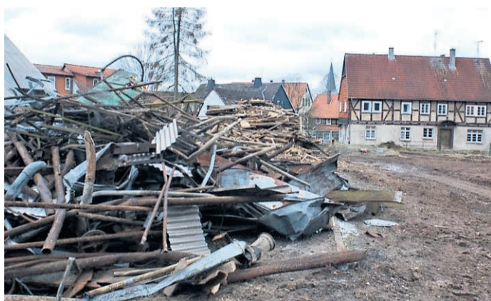
Bauschutt wird getrennt, wiederverwertbares Material soll recycelt werden.
